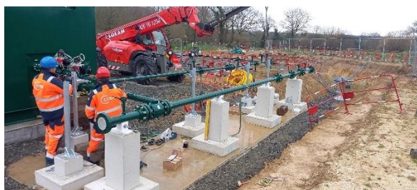
Le rebours en phase chantier
