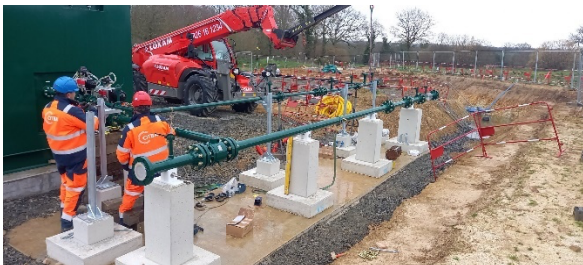
Le rebours en phase chantier
