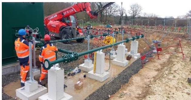
Le rebours de Lamballe en phase chantier
